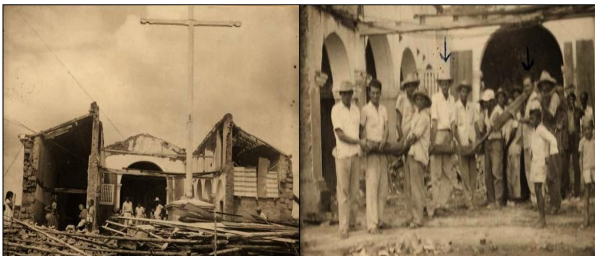
Figura 4: Retirada dos escombros da Igreja Matriz para início da reforma. Fonte: Acervo pessoal de Ana Nery de Carvalho.
