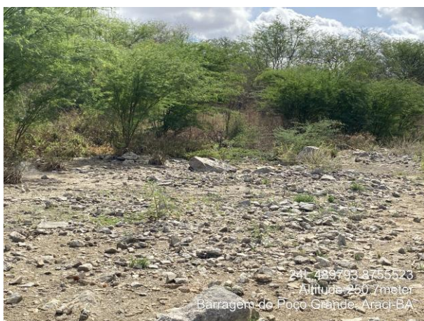
Foto 8 A - Solo no entorno da barragem – Fotografia retirada em campo
