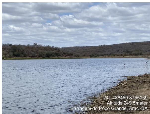
Foto 9 B - Relevo no entorno da barragem – Fotografia retirada em campo
