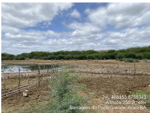
Foto 7 A - Área no entrono da barragem ocupada por Algaroba – Fotografia retirada em campo
