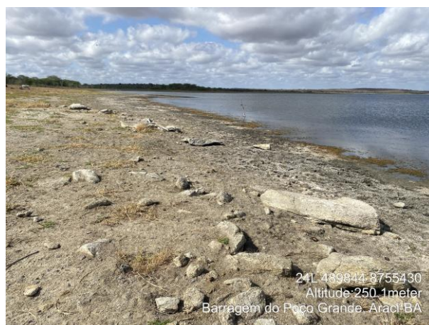
Foto 8 B - Solo no entorno da barragem – Fotografia retirada em campo
