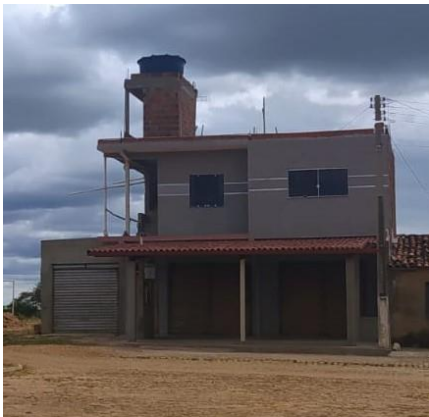
Figura 64: Edificação de dois pavimentos
