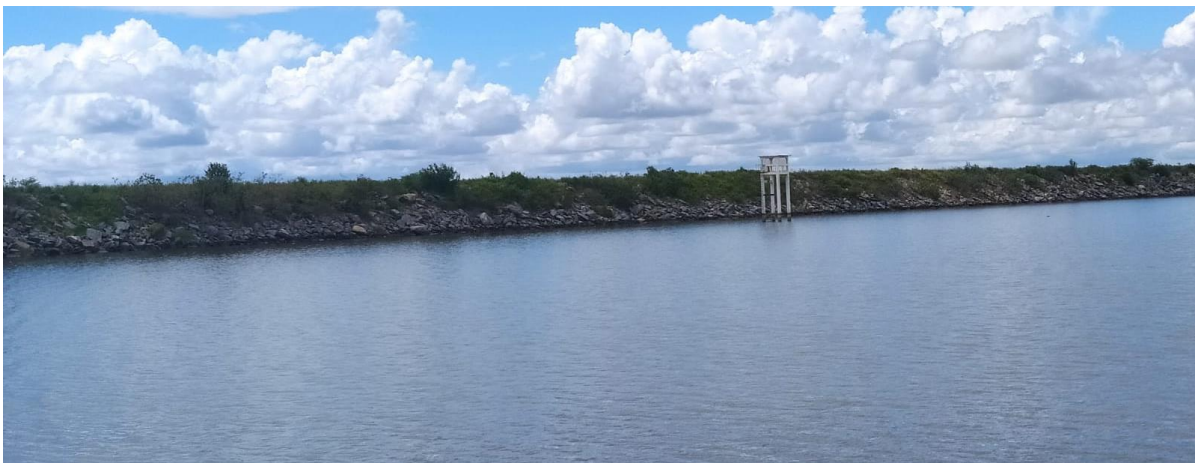
Figura 37: Contenção - Banca do açude.
