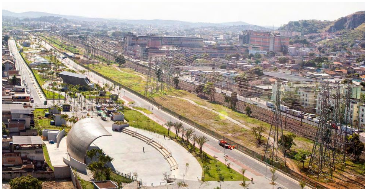
Figura 16: Vista aérea do Parque Madureira.
